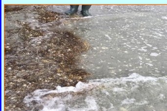
Photo 4: Érosion de la bordure, apparition des racines
