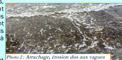
Photo 2: Arrachage, érosion dus aux vagues
